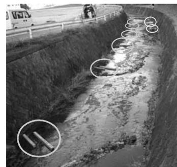
石の水制には、あらかじめ鉄筋を固定した人頭大の石を用いた。水制を作る場所に、土砂をとどめるためにヤシマットを敷き、その上に石を半円状に並べた。石を置く位置にドリルで穴を開け、石の鉄筋を穴にさして固定した。石で囲った内側には、砂や落ち葉などを詰めた。角材の水制は、上流側 100cm、下流側の 150cmの角材を 1 組として用いた。2 本の角材の間を 30cm、2 本目の角材と川岸のコンクリート壁との間を 40cmとし、60°の角度で配置した。角材はアンカーボルトで河床に固定した。このような要領で、左岸側に角材の水制を 6 箇所、右岸側に石の水制を 2 箇所設置した。
