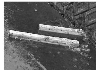
そこで、さらに左上の施工案を考えた。右岸側に、石で囲った枠の中に砂を入れて島を作る。強引に草地を作ってしまうという考えである。左岸側は、カワニナをもっと増やすために、新型と同じような水制にする。ただし、前回の6列型では、間隔が詰まりすぎていて、2列め3列めは、水が滞留してヘドロがたまっておりカワニナの数も少なかったため、水制と水制の間隔を、直線横断型と6列型の間と同じ9mにすることにした。また、2本の角材の長さの差を大きくし、角材の間に流れる水が増えるように計画した。
